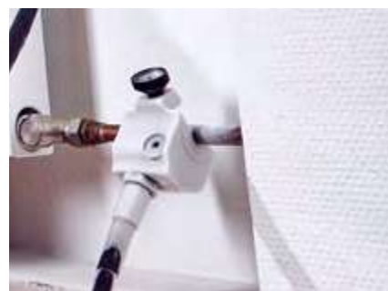
Kompaktna stezaljka za zamrzavanje omogućuje da se cijev zamrzne - čak i blizu zida
